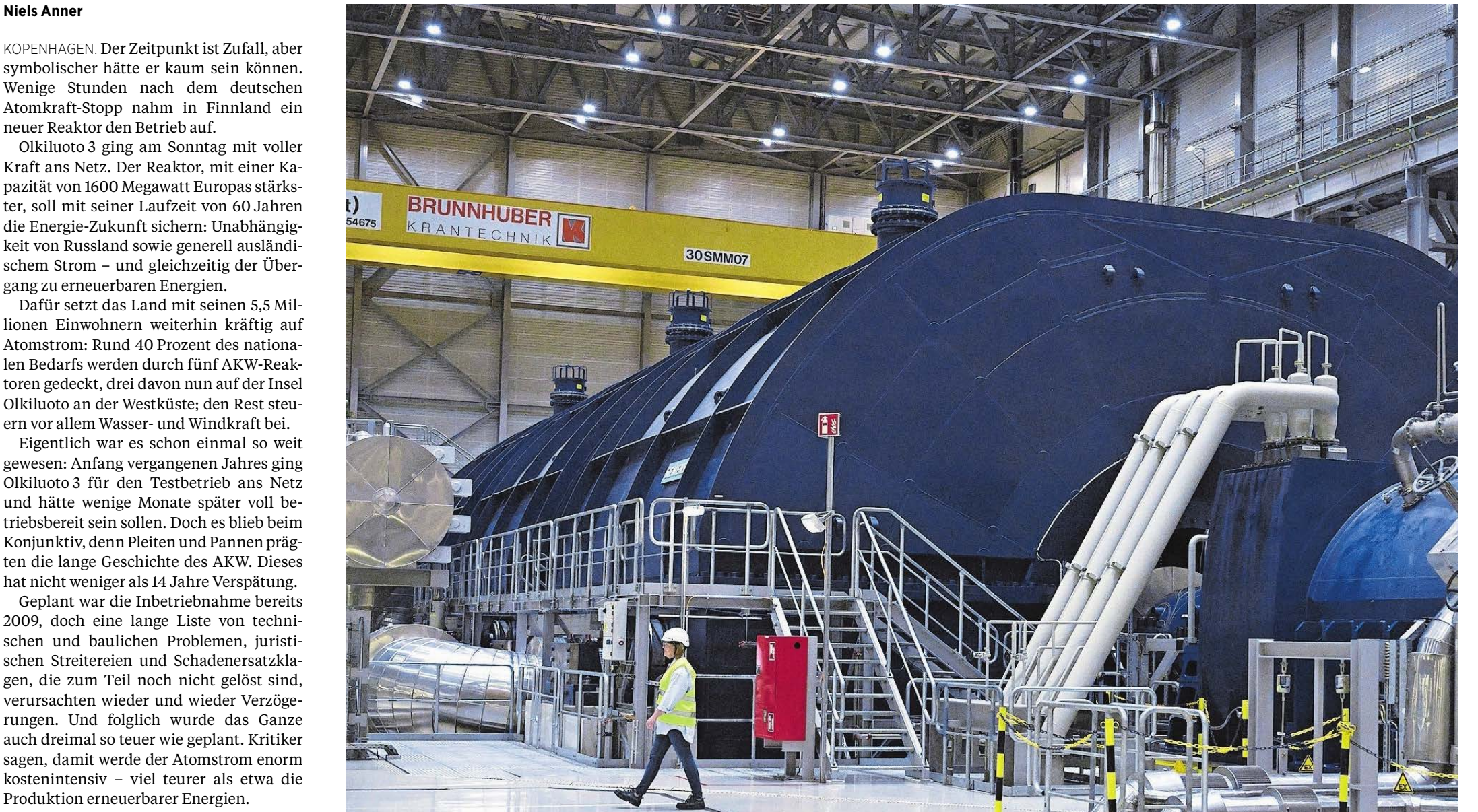
Die finnische Atom-Zukunft ist aufgegleist. Dennoch bleibt offen, ob weiter ausgebaut wird.
